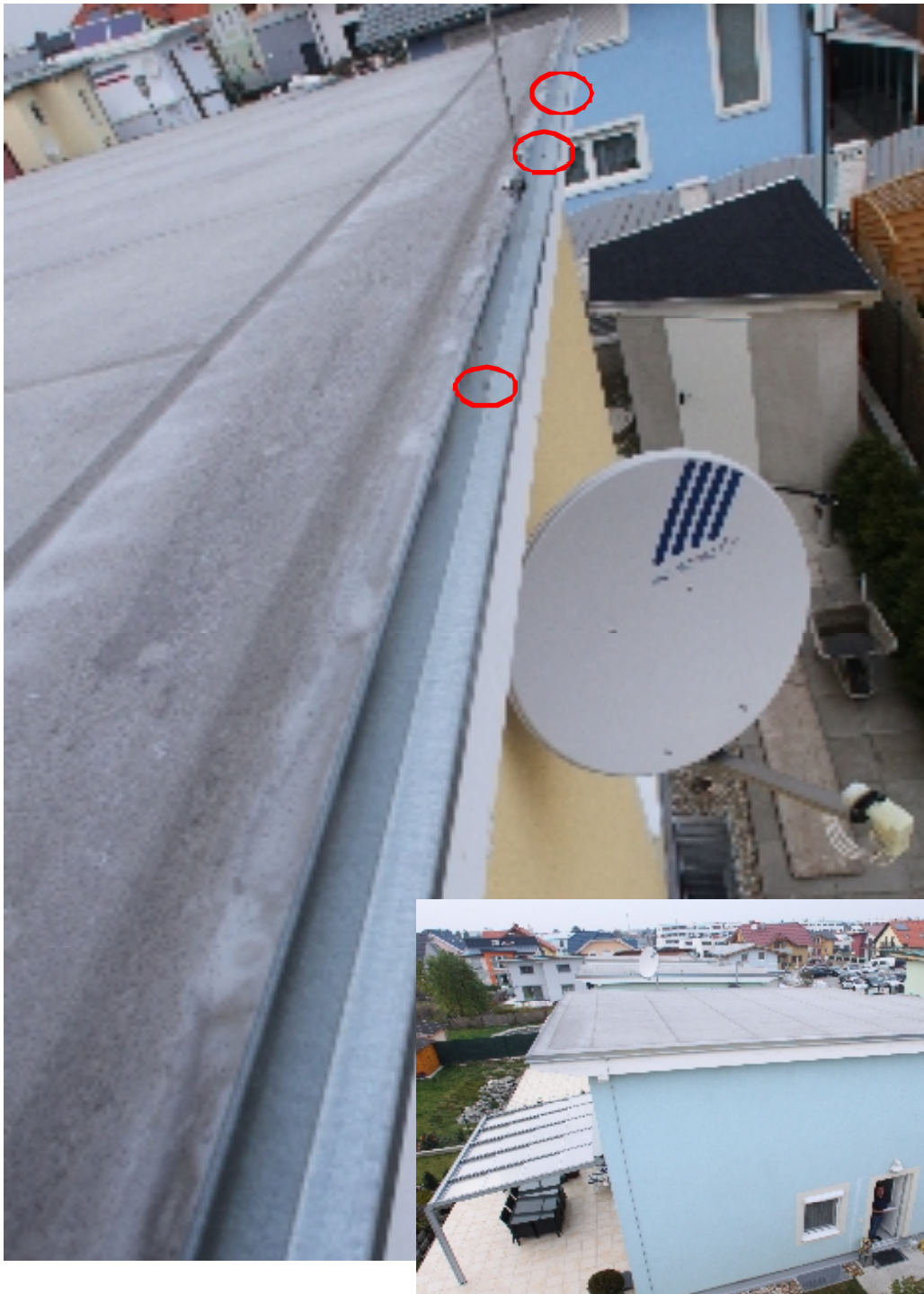
Bild 3,4: Giebeleinfassungen Foliendach
