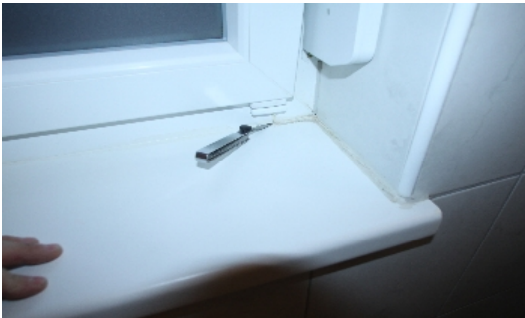
Bild 28: Bauanschlussfuge Fenster-Türe
