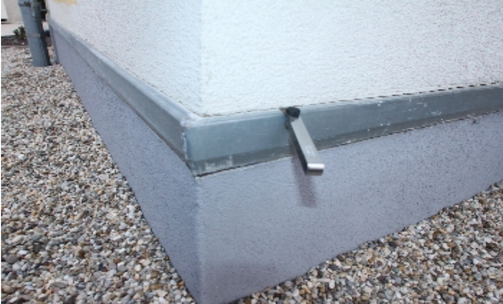
Bild 9: WDVS - Sockelbereich
