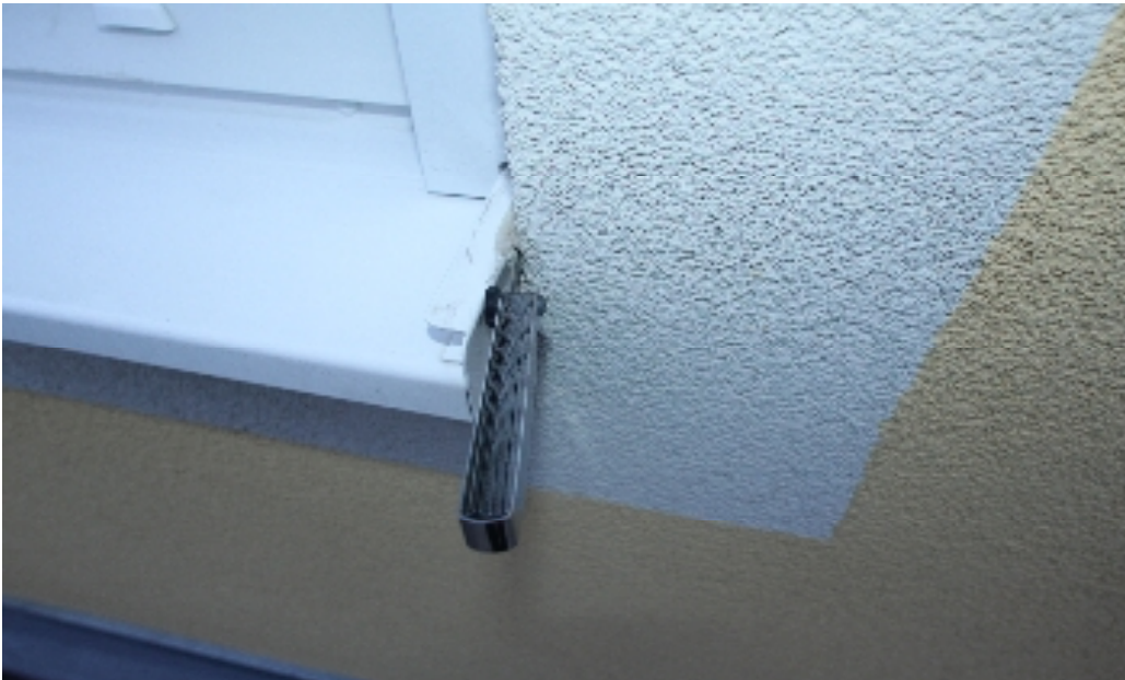
Bild 17: WDVS Sohlbank
