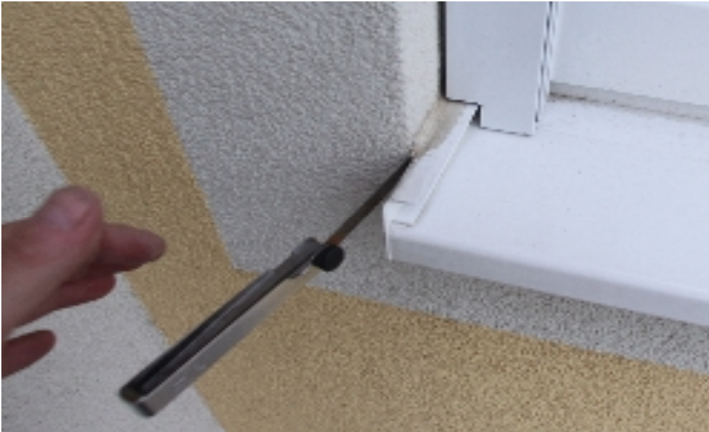
Bild 16: WDVS Sohlbank
