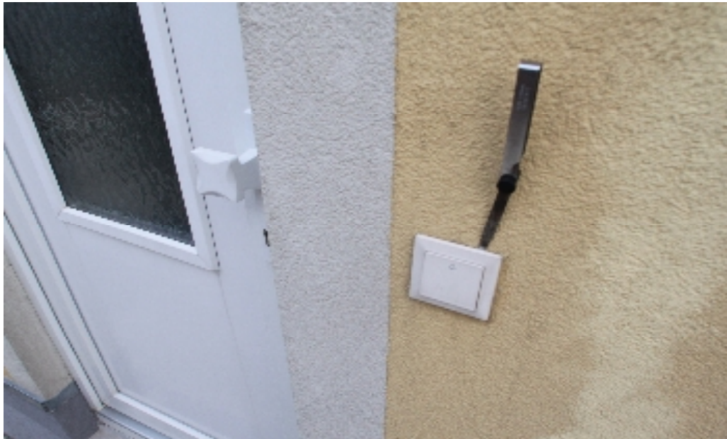
Bild 24: Schlagregensicherheit Elektroinstallationen zu WDVS
