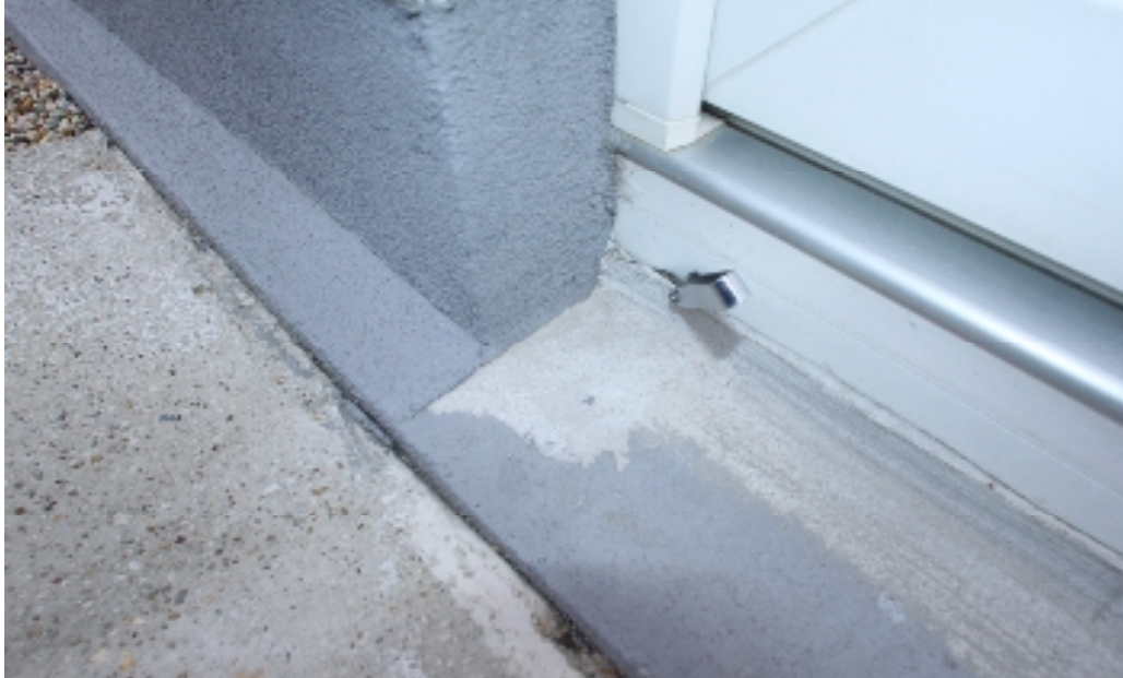
Bild 20: Schlagregendichtung Eingangstüre
