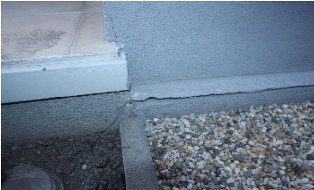
Bild 8: WDVS - Sockelbereich
