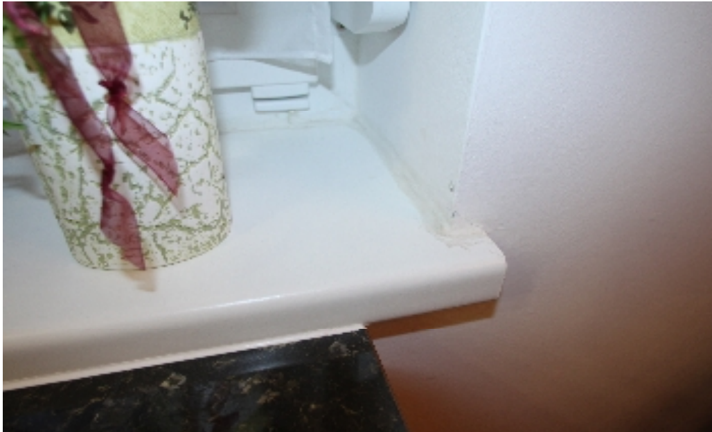
Bild 29: Risse Innenoberflächen
