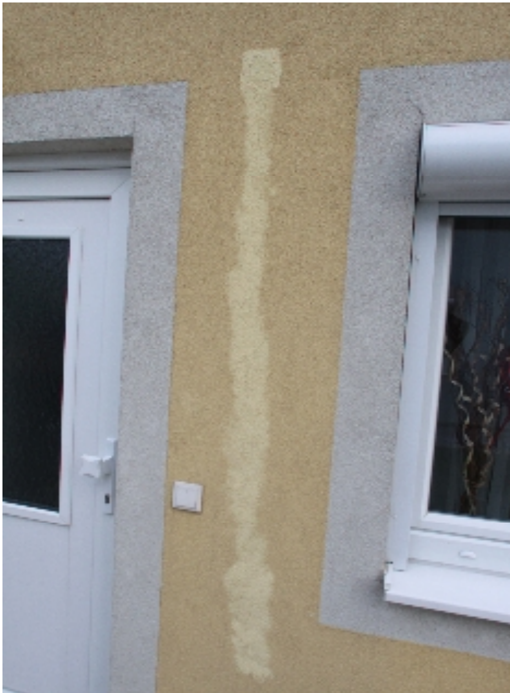
Bild 26: Verlegung E-Installation
