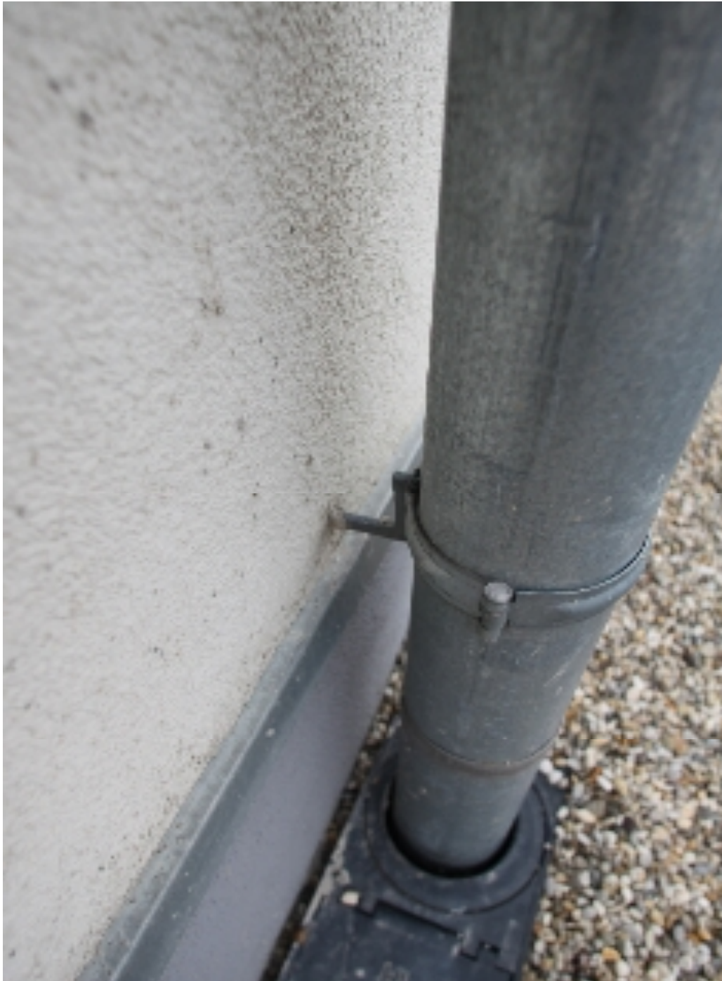
Bild 11: WDVS Fallrohrbefestigung
