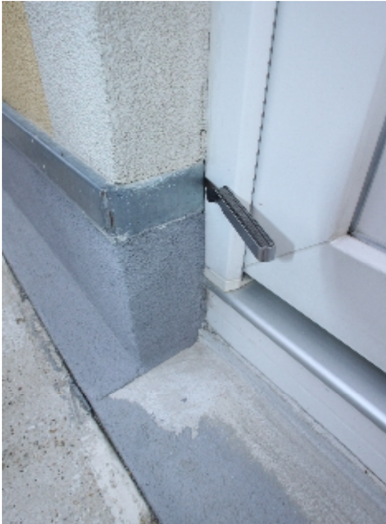
Bild 22: Schlagregendichtung Eingangstüre
