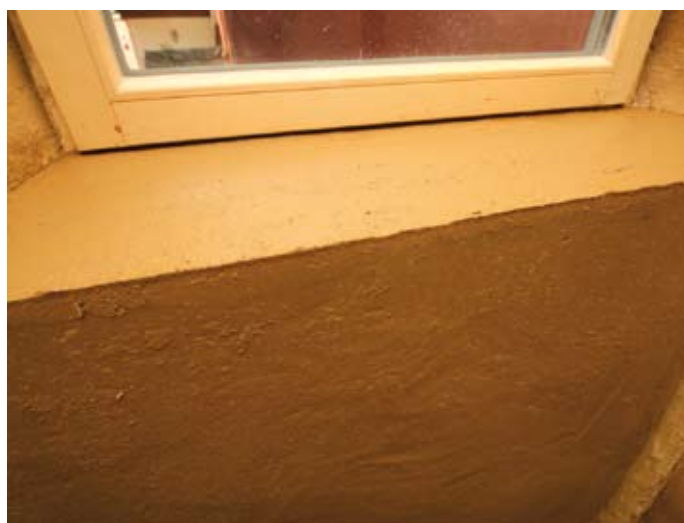
Unterputzlage einer solaren Bauteiltemperierung innerhalb einer ausgemauerten Heizkörpernische unter einem erneuerten Fenster.
