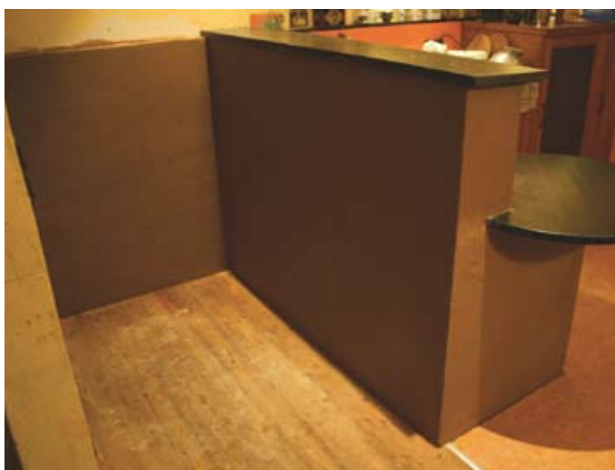
Theke im Essküchenbereich aus Massivlehm mit Wärmetauscher zur Bauteilaktivierung.
