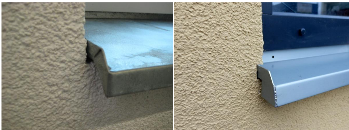
Abbildung 31: handwerklich gefertigte Fensterbänke bei nachträglicher Montage (MW-N)
