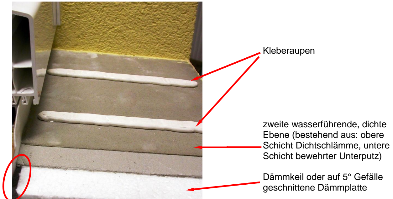
Abbildung 10: Kleberauppen auf zweiter Dichtebebene, auf denen die Fensterbank verklebt wird. Die dabei entstehenden Hohlräume zwischen den Kleberauppen sind zulässig. Der Anschluss des Dämmstoffkeils / Fassadenplatte an das Fensterbankanschlussprofil erfolgt mittels Dichtband
