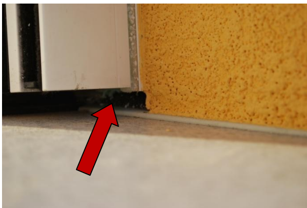
Abbildung 19: offenes Gewerkeloch – hätte vom Fensterbank- oder Sonnenschutzmonteur verschlossen werden müssen
