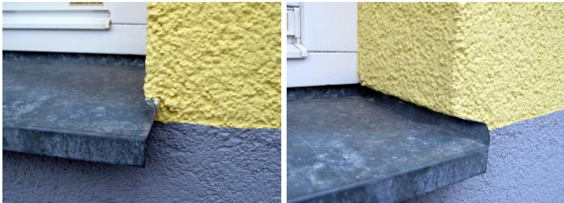
Abbildung 32: Handwerklich gefertigte Fensterbank mit im Gefälle nach innen umgekannten C-Vorkopf worauf die geputzte Leibung bündig angearbeitet wurde. Der seitliche Anschluss erfolgte zuvor mit vorkomprimierten Fugendichtband (Dehnungsaufnahme!).
