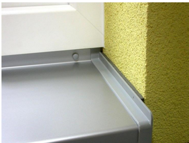
Abbildung 27: nachträgliche Fensterbankmontage - seitlicher Abschluss mit vorkomprimiertem Fugendichtband (BG1)
