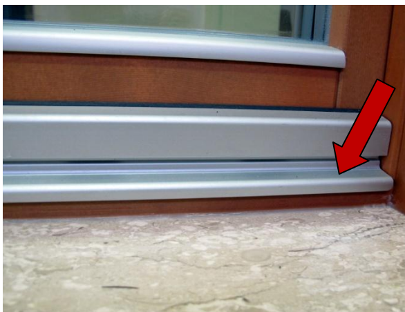
Abbildung 13: Ausführung mit Regenschiene und Wetterschenkel bei stumpfer Montage der Fensterbank an den Fensterrahmen
