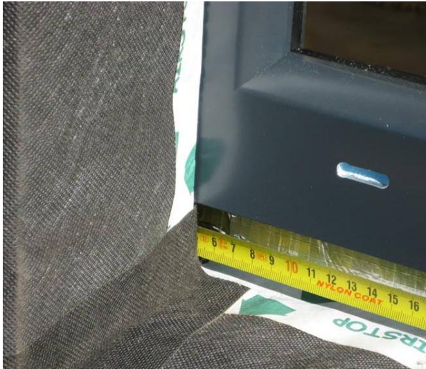
Abbildung 35: Ausführung der zweiten Dichtebene unter der Fensterbank mittels Folien. Da die Vorsatzschale nicht in die zweiten Dichtebene entwässert, sondern dahinter, ist darauf zu achten, dass der Eckbereich der Vorsatzschale gesondert verschlossen/ abgedichtet wird (siehe Pkt. 5.2). Das Gewerke Loch ist ebenfalls am besten mittels Dichtmasse zu verschließen.
