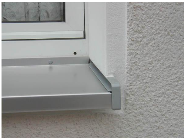
Abbildung 25: eingeputztes Gleitabschlussprofil mit federnder Wirkung - Beispiel und Prinzipskizze
