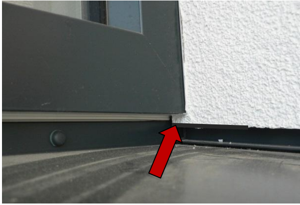
Abbildung 20: geschlossenes Gewerke Loch - vom Fassadenhersteller verschlossen
