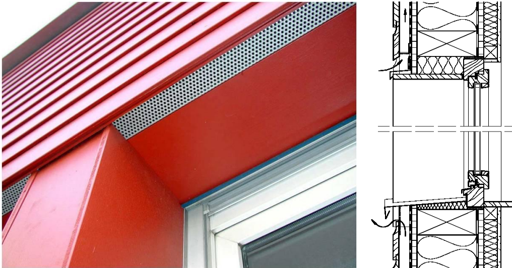
Abbildung 33: Zu- und Abluftöffnungen bei hinterlüfteter Fassade (Quelle: Fassaden aus Holz; Holzforschung Austria)
