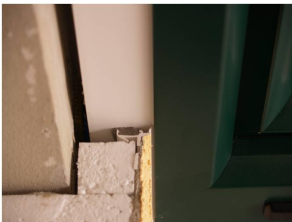
Abbildung 22: Fenster mit Vorsatzschale als Halbschale ausgeführt, Darstellung des Leibungsanschlusses
