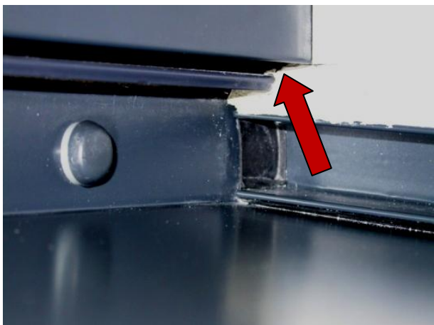
Abbildung 18: Fensterrahmennuten / Vorsatzschalennuten; z.B. Verschießen der Nuten mittels Dichtmasse
