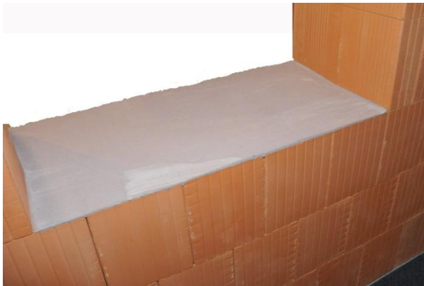
Abbildung 6: Glattstrich auf Ziegelmauerwerk am Parapet, um konvektionsbedingtes Kondensat zu vermeiden
