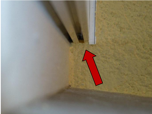
Abbildung 1: Beispiel Fensterrahmennuten
