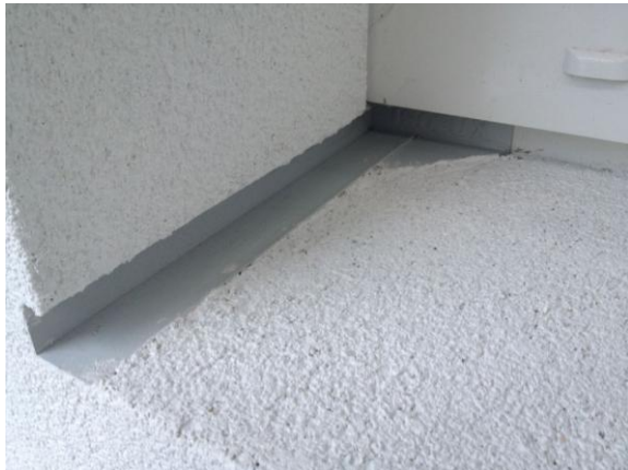
Abbildung 29: links: Putzprofil für eine Fensterbank-Montagevorbereitung mit einer zweiten zusätzlichen Dichtebene; rechts: mit später eingeschobener und montierter Steinfensterbank
