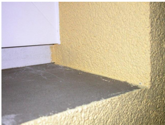
Abbildung 28: Zweite Dichtebene mittels fertig beschichtetem Parapet (Dichtschlämme inkl. seitlich überputztem Hochzug)
