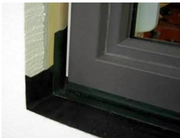
Abbildung 30: Zweite Dichtebene, welche wannenförmig an den Fensterrahmen mittels Folie und Klebeband angeschlossen wird. Seitlich in der Leibung sollte die Folie mind. 6 cm hochgezogen werden
