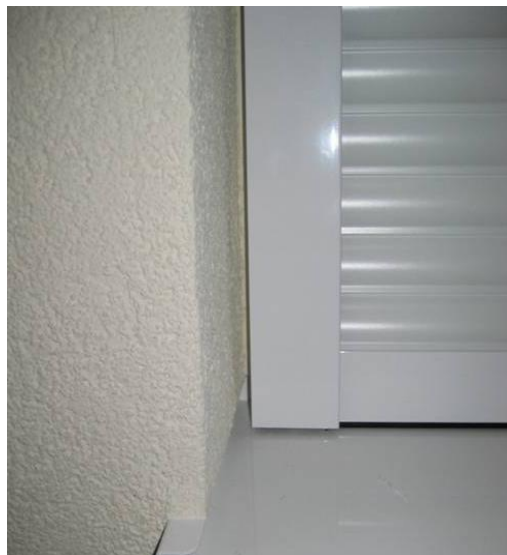
Abbildung 24: nachträglich montierte vorgesetzte Sonnenschutzschiene
