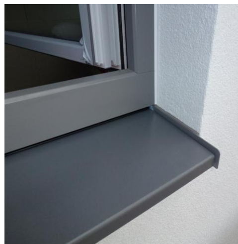
Abbildung 27: nachträgliche Fensterbankmontage - seitlicher Abschluss mit vorkomprimiertem Fugendichtband (BG1)
