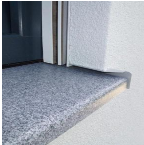
Abbildung 23: eingeputzte Sonnenschutzführungsschiene mit ausgeklinktem Endprofil
