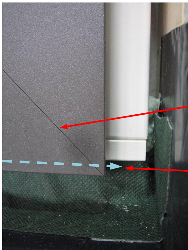
Abbildung 17: Die gesamte Vorsatzschale aus Aluminium liegt innerhalb der zweiten wasserführenden, dichten Ebene, welche mit Klebefolien wannenförmig ausgeführt wurde
