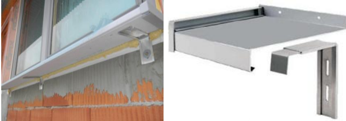
Abbildung 8: Fensterbank mit Fensterbankhalter; Beispiel eines Fensterbanhalters
