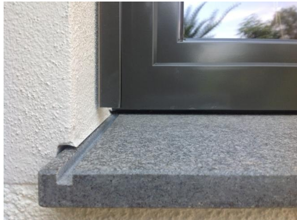
Abbildung 29: links: Putzprofil für eine Fensterbank-Montagevorbereitung mit einer zweiten zusätzlichen Dichtebene; rechts: mit später eingeschobener und montierter Steinfensterbank
