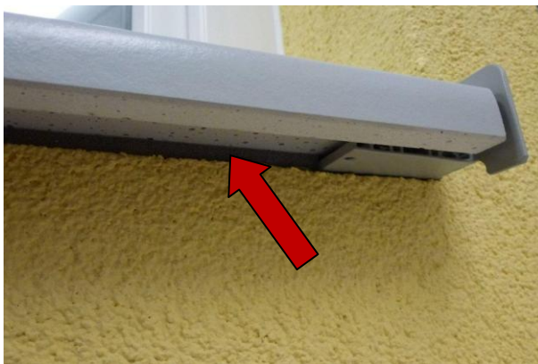
Abbildung 11: Aus optischen Gründen mit einem diffusionsoffenen, dekomprimierten Dichtband geschlossene Fuge
