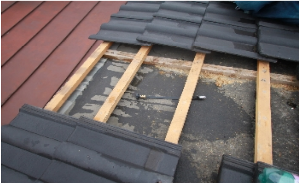
Bild 19: Schauöffnung 1 - direkt über Wasserschaden
