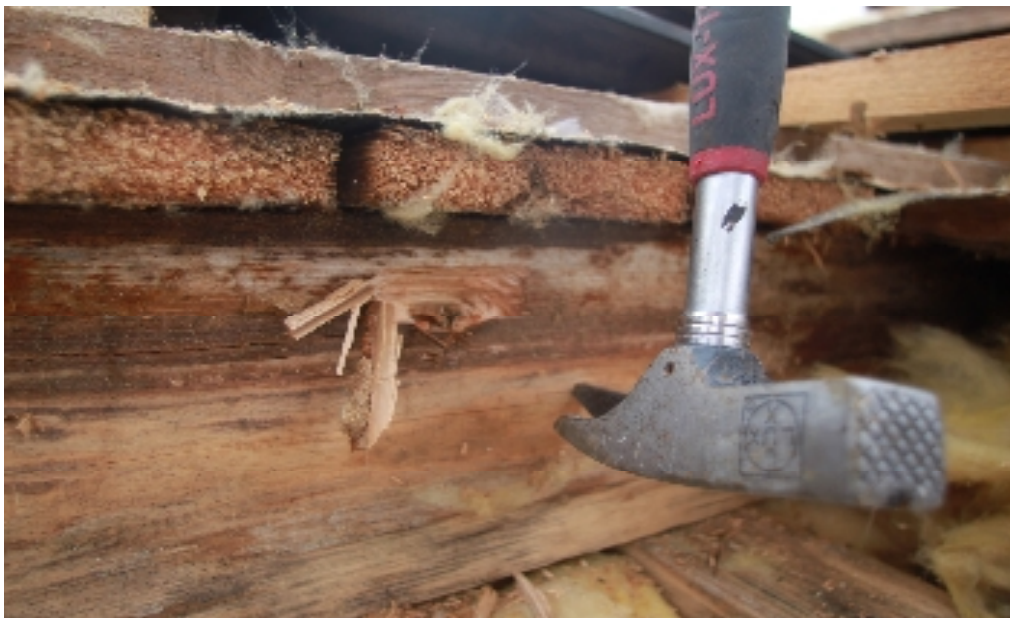
Bild 24: Schauöffnung 1 - direkt über Wasserschaden
