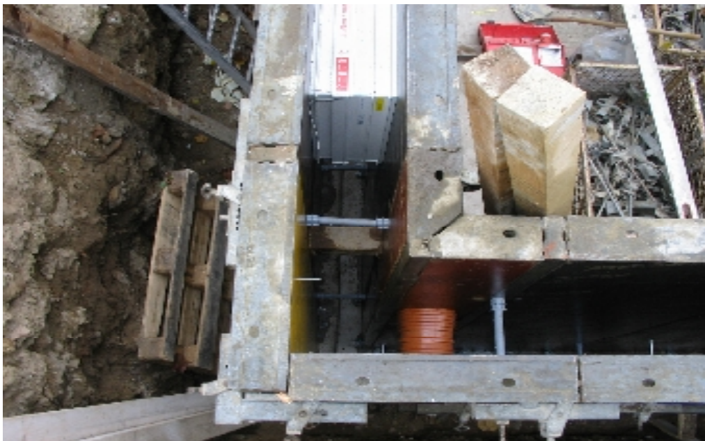
Bild 4: Betonierarbeiten Kellerwand
