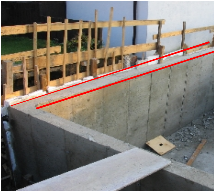
Bild 6,7: Betonierarbeiten Kellerwand + Rissabdichtung
