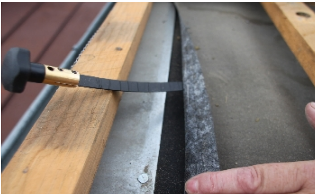
Bild 20: Schauöffnung 1 - direkt über Wasserschaden
