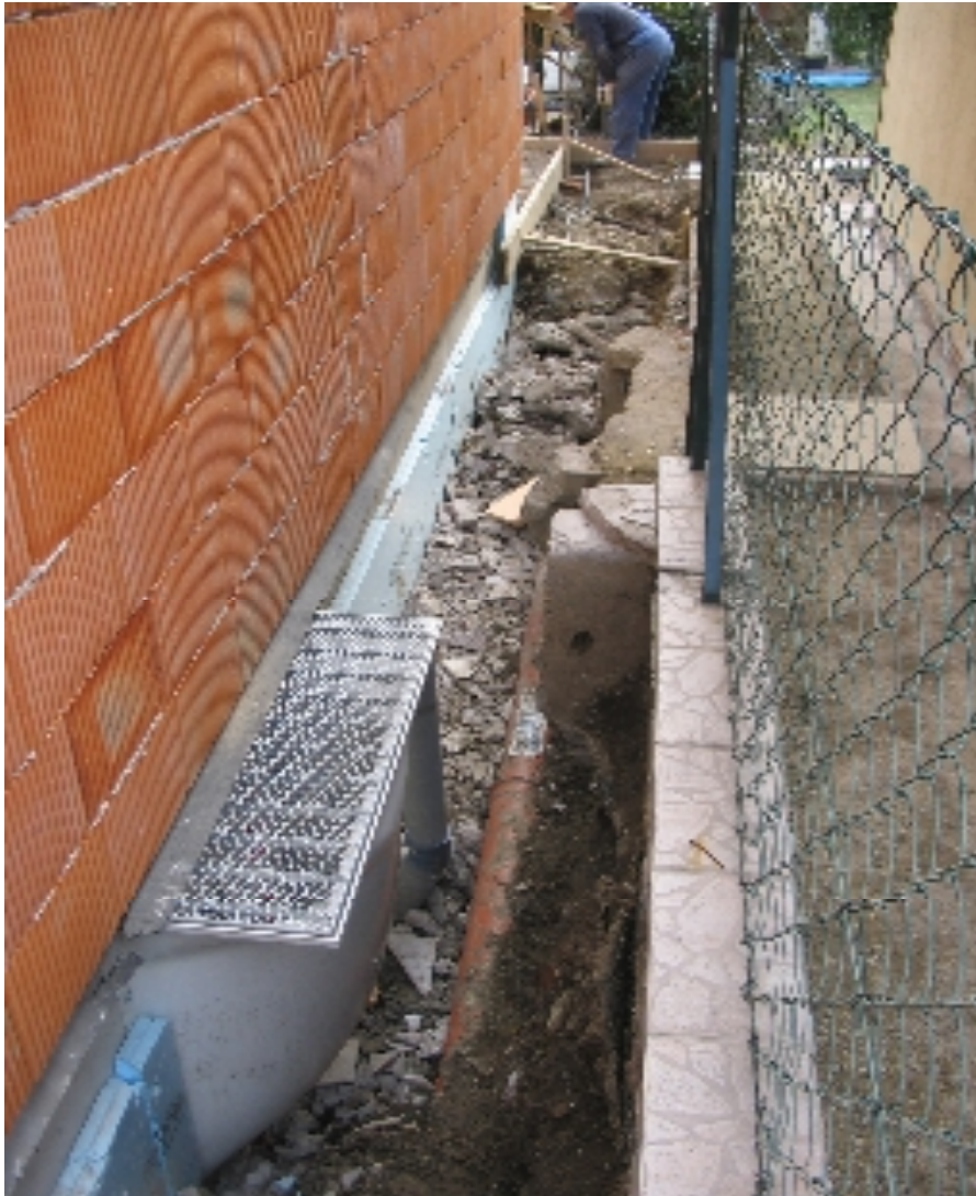
Bild 36: Kanalrohre
