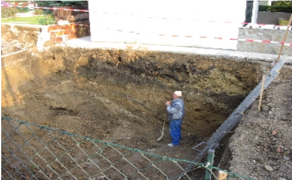
Bild 1: Baustellenbild - Aushub Keller
