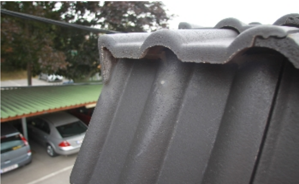
22) Die Firstschare im Bereich des steilen Mansardendaches ist fehlerhaft ausgeführt, die "Nasen" wurden abgeschnitten und der Dachstein jeweils mit einem 22) blanken, nicht wie in der ÖNORM B2219; B7219 vorgeschriebenen feuerverzinkten Nagel befestigt. Der Nagel ist 23) frei bewittert und in nicht zulässiger Weise mit Silikon verschmiert
