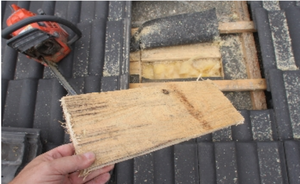
21) Bretterschalung an der Innenseite leicht mit Schimmelpilzen befallen.
