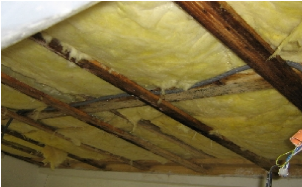
Bild 16: Erste Wasserschaden
