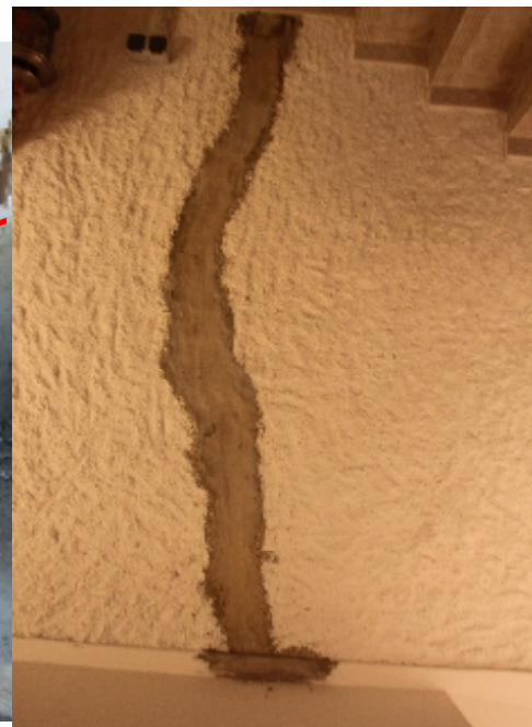
Bild 6,7: Betonierarbeiten Kellerwand + Rissabdichtung
