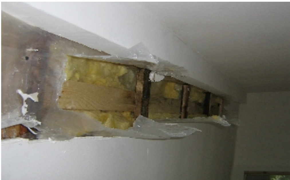
Bild 15: Erste Wasserschaden
