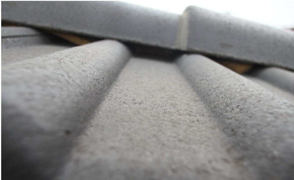
Bild 32: Dachdeckung - First
