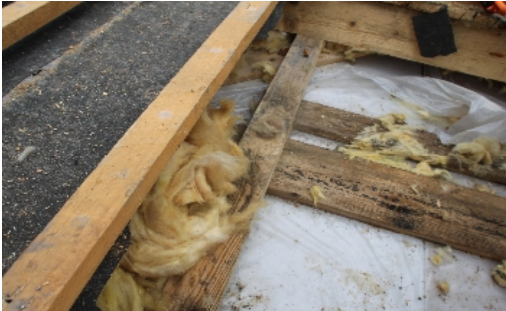
Bild 23: Schauöffnung 1 - direkt über Wasserschaden
