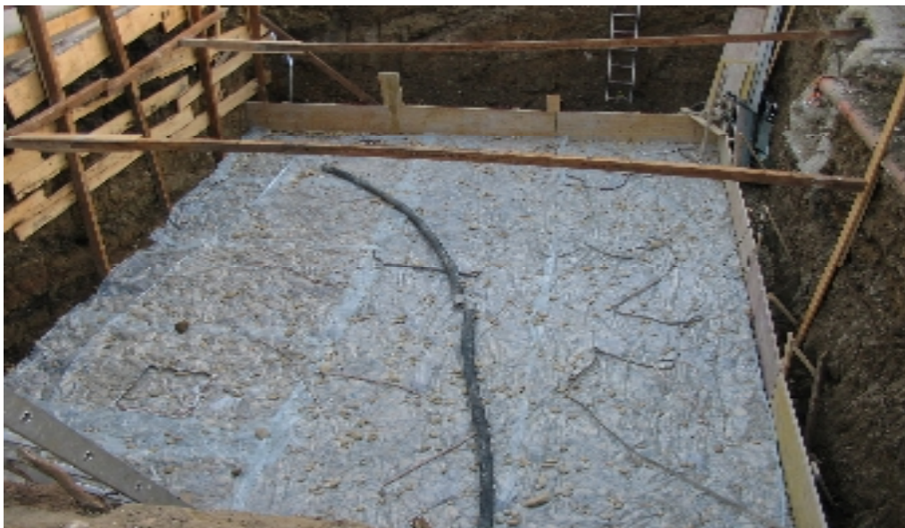
Bild 2: Vorbereitung Bodenplatte Keller
