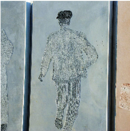
Flowstone-Stelen mit Farbpigmenten: Abbindeverzögerer verlangsamen das Abbinden der Oberfläche, die sich dann auswaschen lässt, gleichmäßig oder in Form bildlicher Darstellungen.
