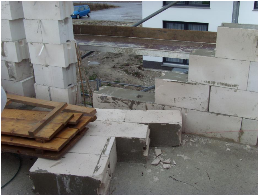
Fehlender Haftverbund führt zu Einsturz
